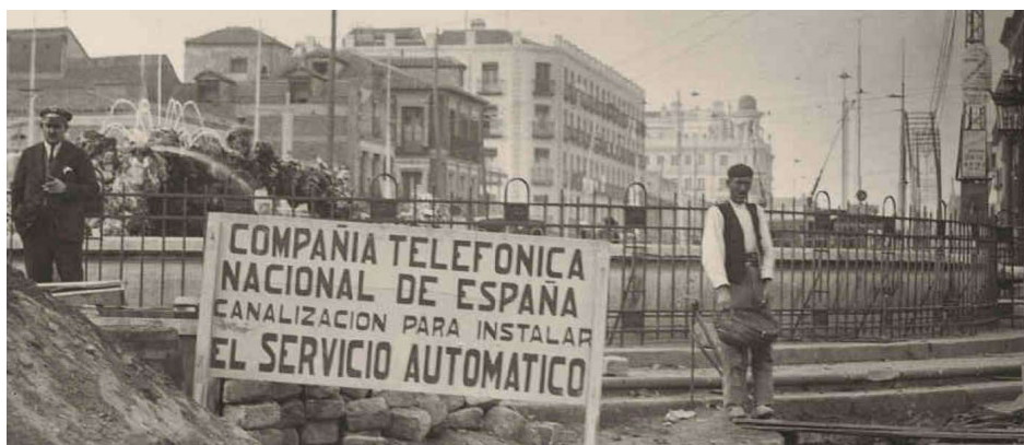
Obras de infraestructura de la Compañía Telefónica, creada en 1924.
