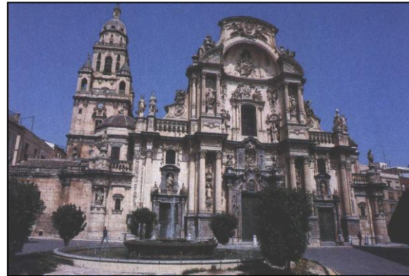
36. Fachada de la catedral de Murcia. J. Bort.
