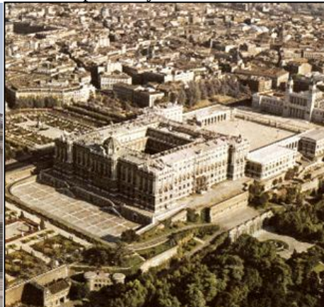
42. Palacio Real de Madrid. Vista aérea. Filippo Juvara.
