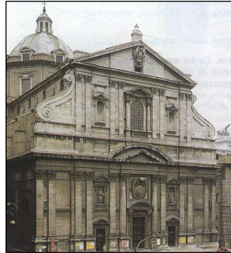
8. Fachada de Il Gesù. Giacopo della Porta.
