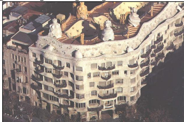
30. Vista aérea de la Casa Milà (La Pedrera). Gaudí.
