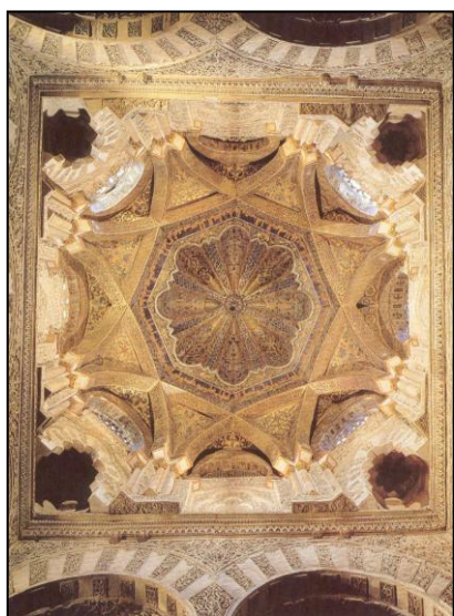
15. Cúpula gallonada octogonal
