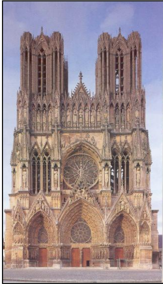
18. Fachada de Reims.
