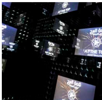
Interior de un elevador de alta velocidad, ©Emaar Properties PJSC
