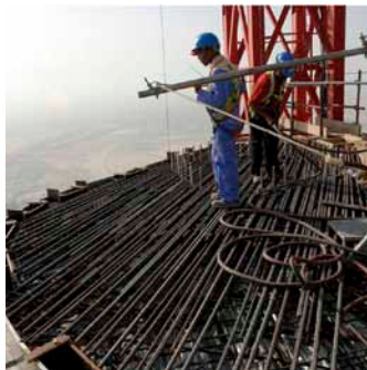
Construcción de un entramado de barras de acero corrugado, ©Emaar Properties PJSC
