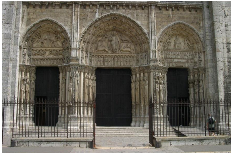
El Pórtico Real en la fachada occidental de Chartres.
