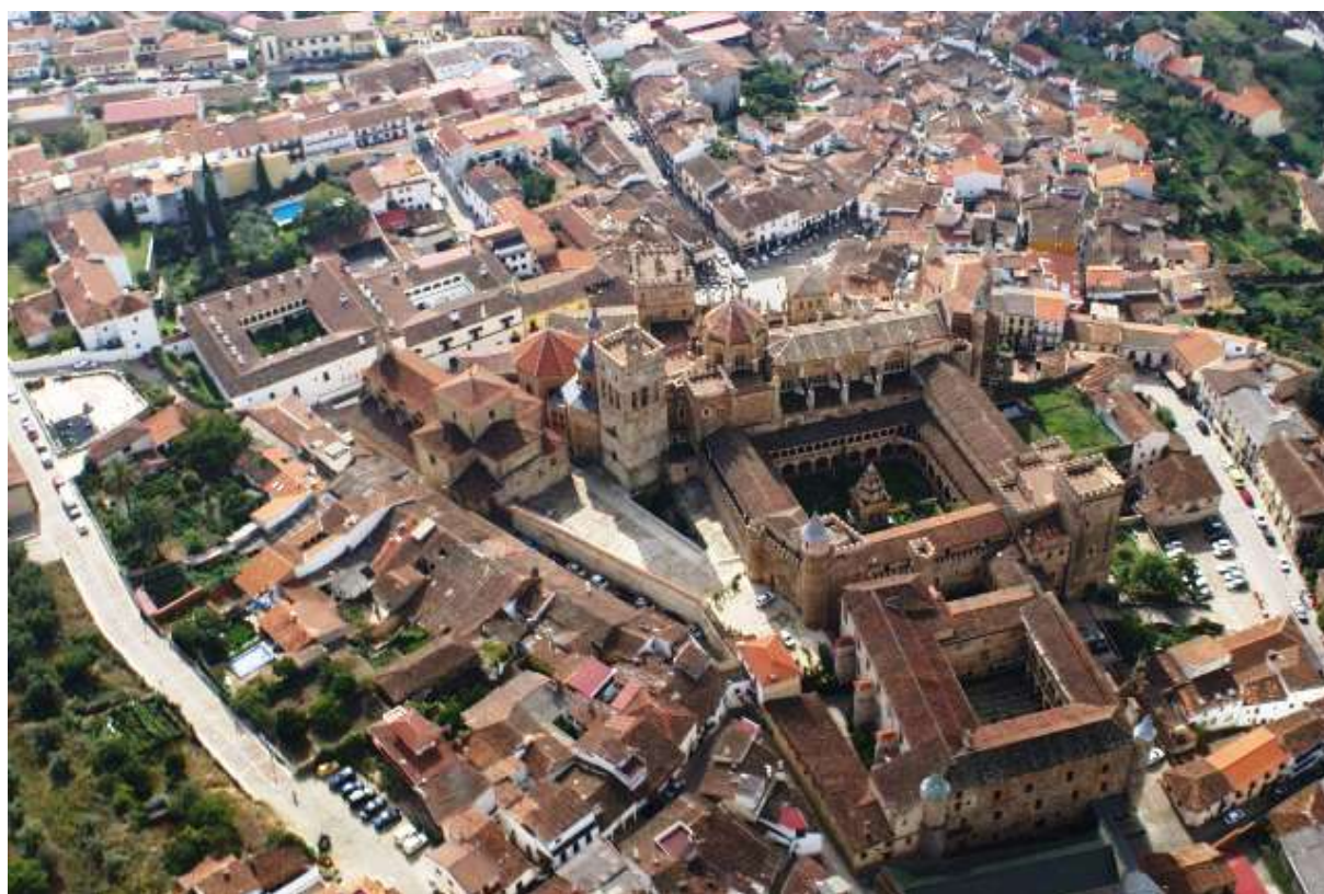
Vista aérea del conjunto.
