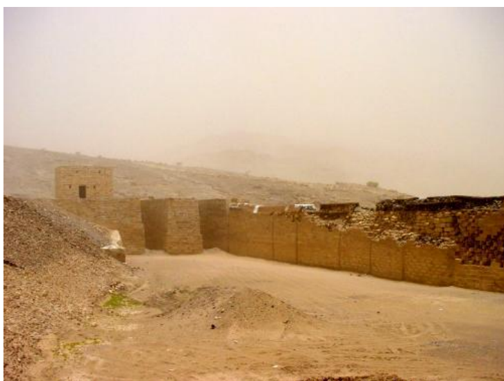
Restos de la gran presa de Marib.
