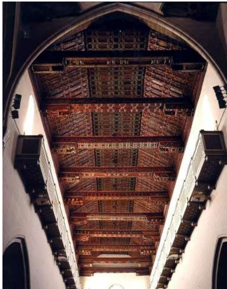
Vista general de la techumbre de la catedral de Teruel.
