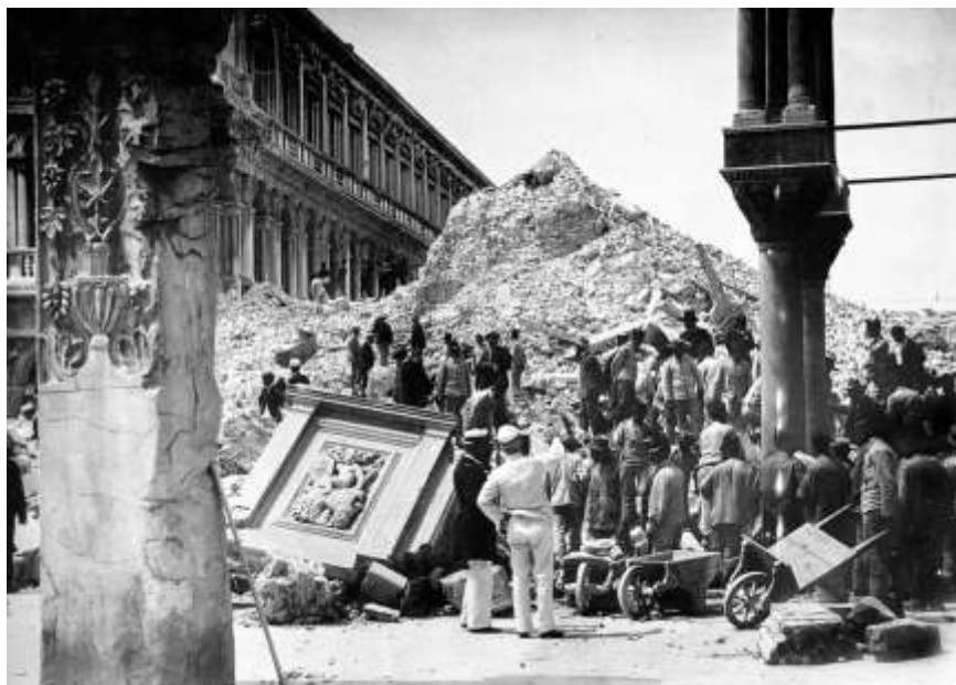
Fotos de la torre recién derrumbada el mismo día 14 de julio.
